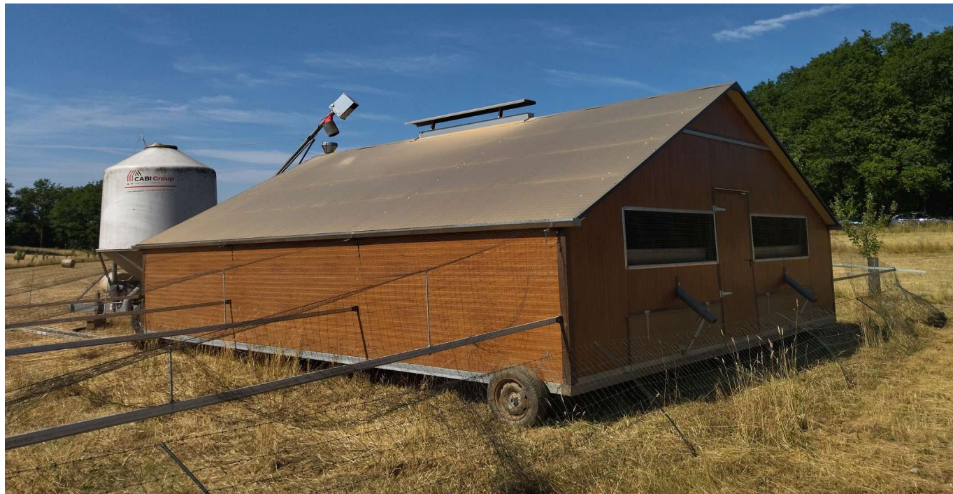
Face arrière du poulailler - portes automatiques programmables pour la sortie des poules - fenêtres et ventilation arrière et au faîtage
