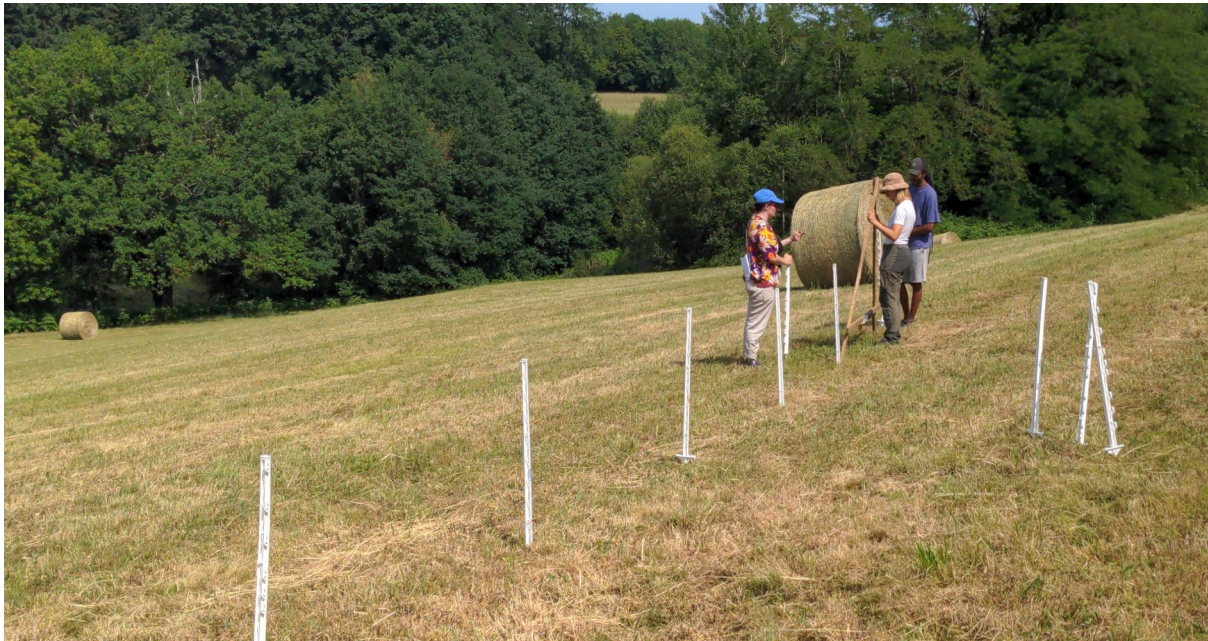
Utilisation du niveau égyptien pour piqueter la courbe de niveau tous les 2m
