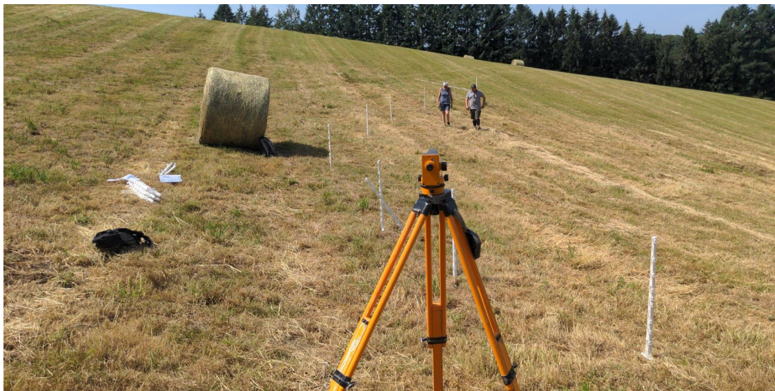
Piquetage d'une courbe de niveau à l'aide du niveau optique
