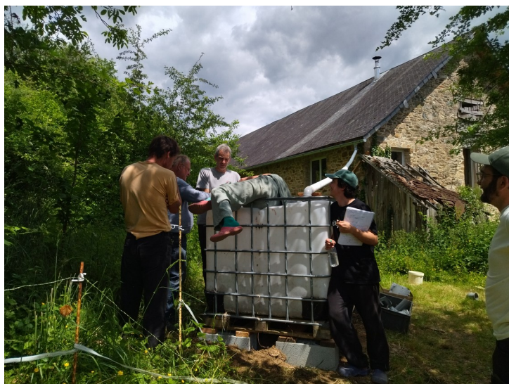
Etape 3 : placer le passe-paroi sur cuve 2
