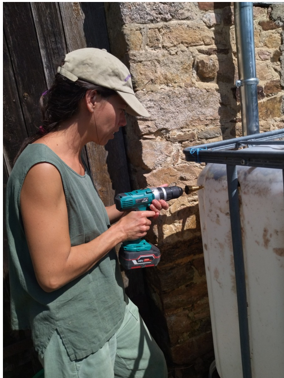
Etape 4 : percer avec un foret étagé
